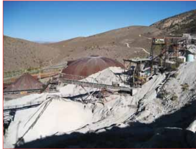
图 3. 一级和二级破碎工序，背景为预均化库的圆顶。
